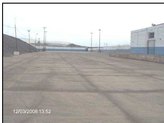
Vista del Patio de contenedores y zona de carga
