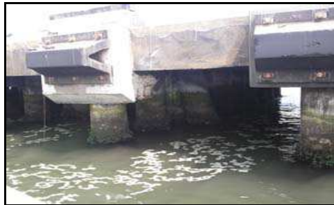
Pilotes y defensas del Muelle 1
